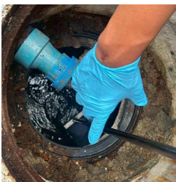
รูปที่ 3.2 จุดระบายน้ำออกจากระบบบำบัดน้ำเสีย บริเวณระบบบำบัดน้ำเสีย อาคาร C
